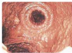
築50年の一般住宅の(水道管内をファイバースコープで撮影)例
